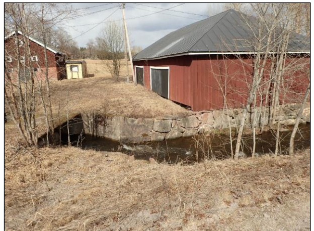
Betoninen silta ja lohkokivistä tehty rantamuri.
