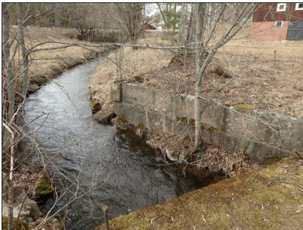
Betoninen silta ja lohkokivistä tehty rantamuri.
